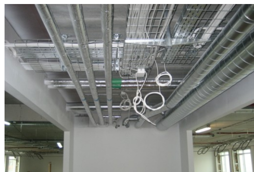
Figure 90 – Actual cable tray installation
