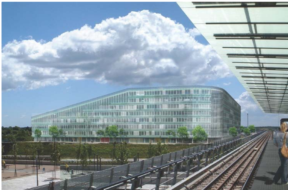
Fig1: Illustrationen viser Rambøll Head Office i en tidlig fase af projekteringen, hvor arkitekten har anvendt arkitektfagmodellen til visualisering.
