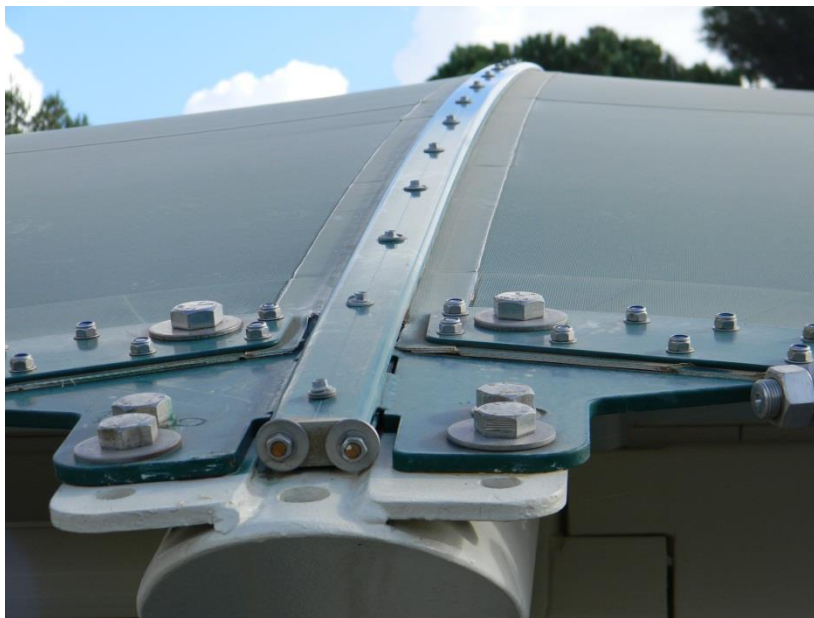
FIGUR 14-2: INDSPÆNDT MEMBRAN PÅ BUE [ 16 ]
